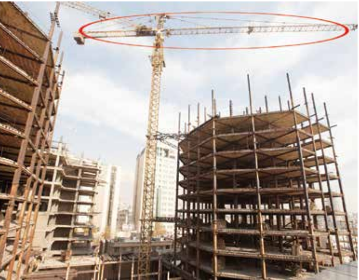
ساختمانی که سی سال در یکی از خیابانهای تهران نیمه کاره رها شده است
